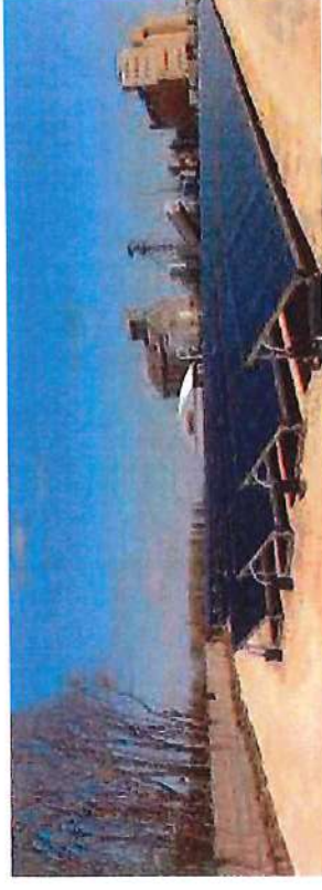
Centrale solaire thermique pour une malterie (dépt 36) - 14 250 m 2 - 8 000 MWh/an
